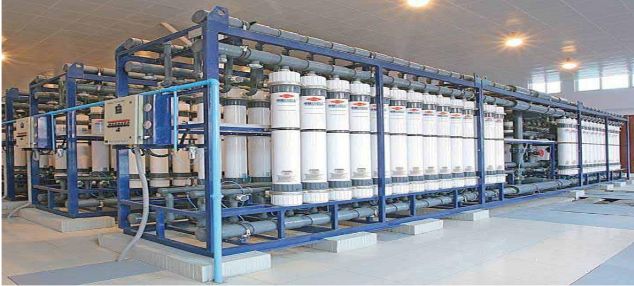
شكل رقم 1-13: شكل وحدة ترشيح فائق الدقة (Ultra Filtration).
